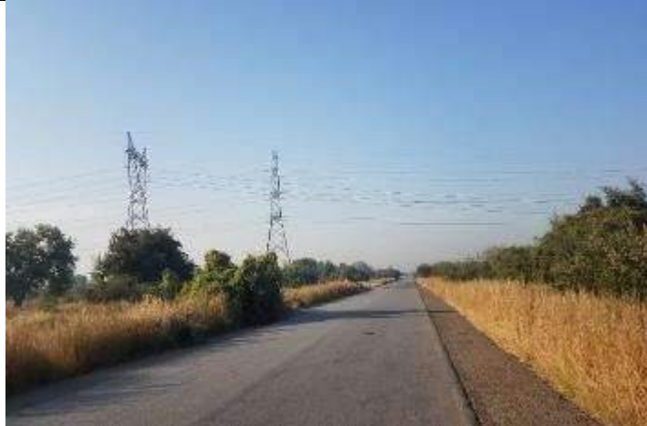
Lignes inter connexion Mali-Sénégal traversant la route
